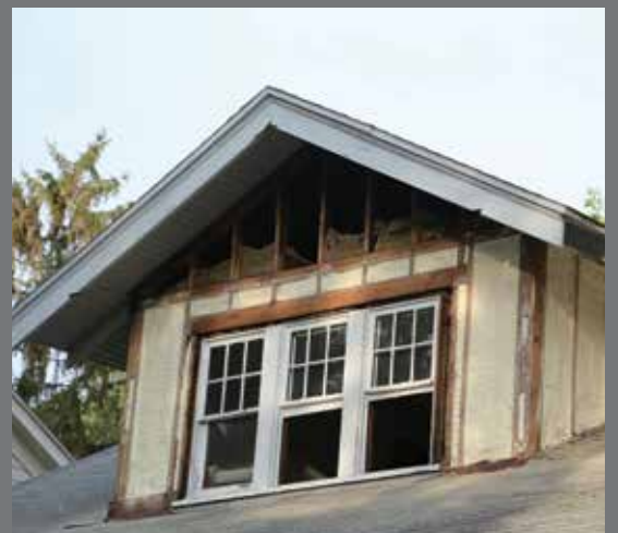
現場発泡ウレタンフォーム断熱材施工後
