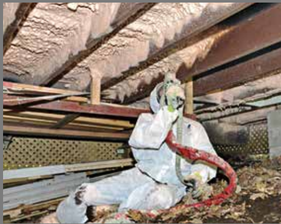
施工の様子 - 安全ガイドラインに従い、適切な保護具を装着した施工技術者による吹付作業
