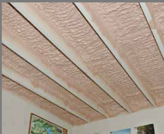
新しく設置した壁システムユニット。現場発泡ウレタンフォーム断熱材を隙間なく施工。しっかりと密着し、スムーズな表面。
